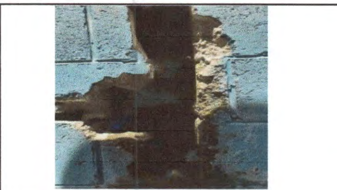
Foto 4: Sustitución de tubería línea principal
