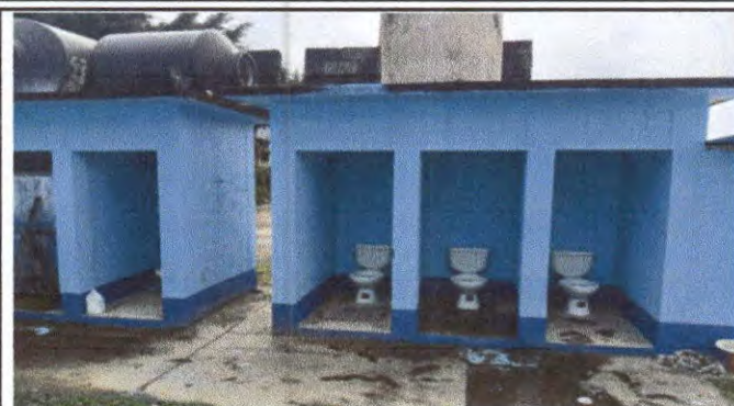
Foto 2: Sustitución de puerta en servicios sanitarios
