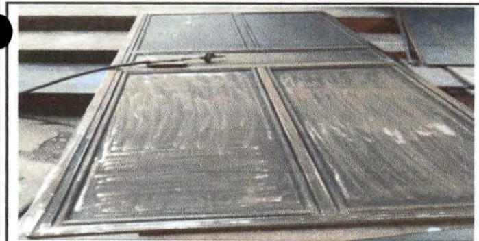
Foto 5: Mantenimiento a estructura ( lijado, cambio de tubo, cepillado, sujeciones, aplicación de pintura
