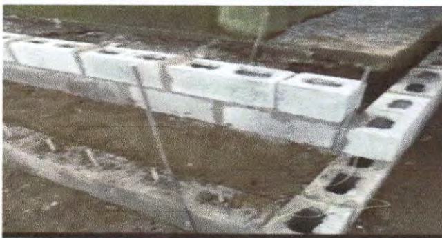
Foto 11: Reparación de muro de contención
