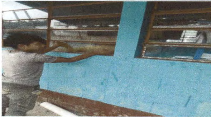
Foto7: Sustitución de vidrios
