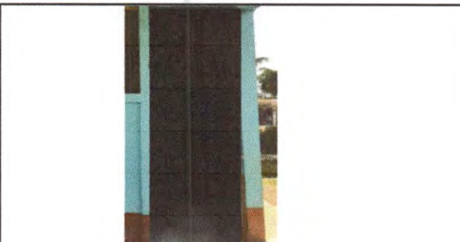
Foto 6: Sustitución de puerta ( 3x1 metro)
