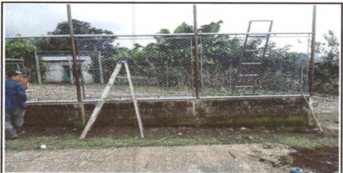
Foto 12: Reparación de tubo hg y malla galvanizada
