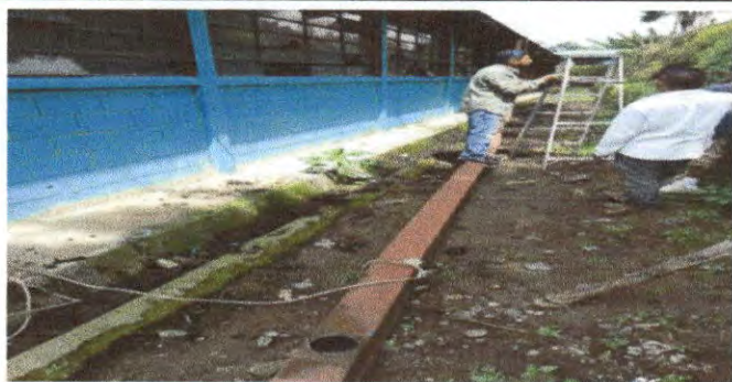
Foto 9: Reparación de bajada de agua pluvial tubo PVC 3"
