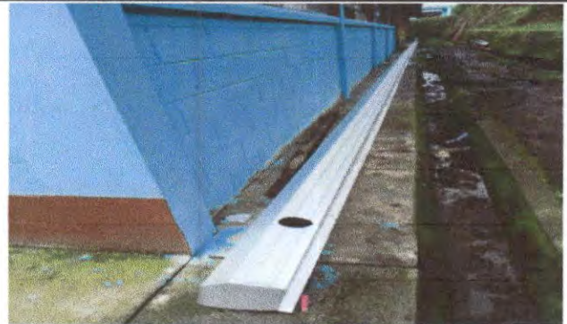
Foto 8: Sustitución de canal de metal
