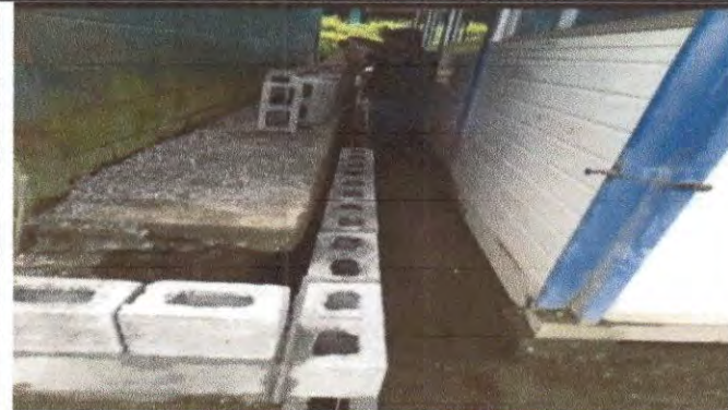
Foto 10: Reparación de banquetas de concreto
